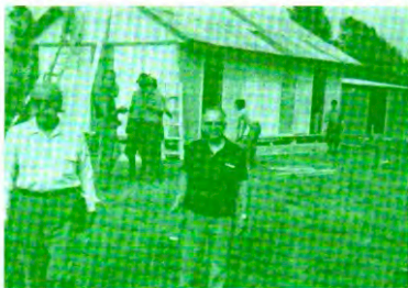
Si montano le baracche. In primo piano il Gen. Ferrero e Pozzi
