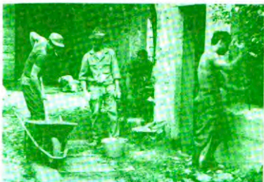
Fervono i lavori
